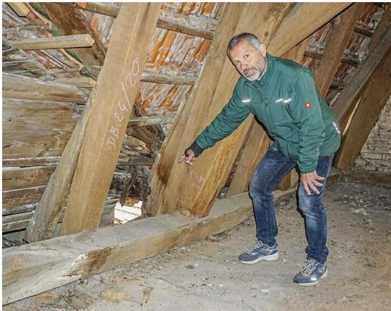
Im Dachstuhl des historischen Niemeyerhauses haben die Fachwerk-Freunde Hönebach einen Schaden entdeckt. Ein tragender Balken ist von einem Pilz befallen, der das Holz zersetzt. „Der Balken trägt einen Teil der Dachlast, daher müssen wir das Dach teilweise zurückbauen und abstützen“, sagt Vereinsmitglied Siegfried Linß. Die Sanierung kostet 90.000 Euro. Das Landesamt für Denkmalpflege hat Unterstützung zugesagt, weitere Fördermittel werden gesucht.
