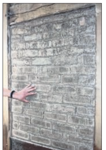
So wie einst: Um das Fachwerk zu füllen, haben die Vereinsmitglieder eigenhändig Lehmziegel hergestellt.
