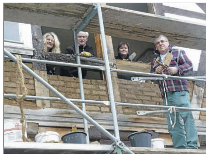
Ein paar der fleißigen „Handwerker“ in Aktion: Fast alle Gefache des oberen Stockwerks konnten ausgemauert werden. Foto: nh
